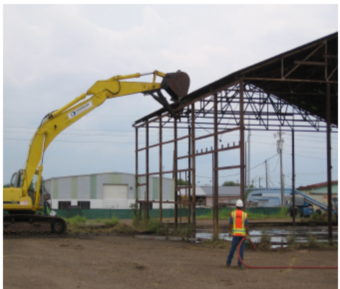
El desmontar del almacén de metal (edificio de almacenaje).
